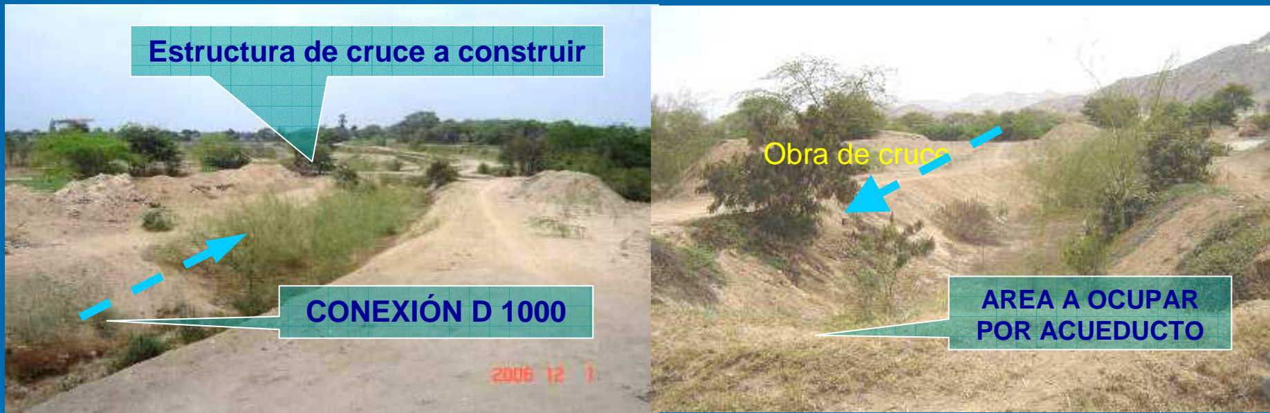
FOTOS DE LA ZONA ANTES DEL INICIO DE LAS OBRAS
