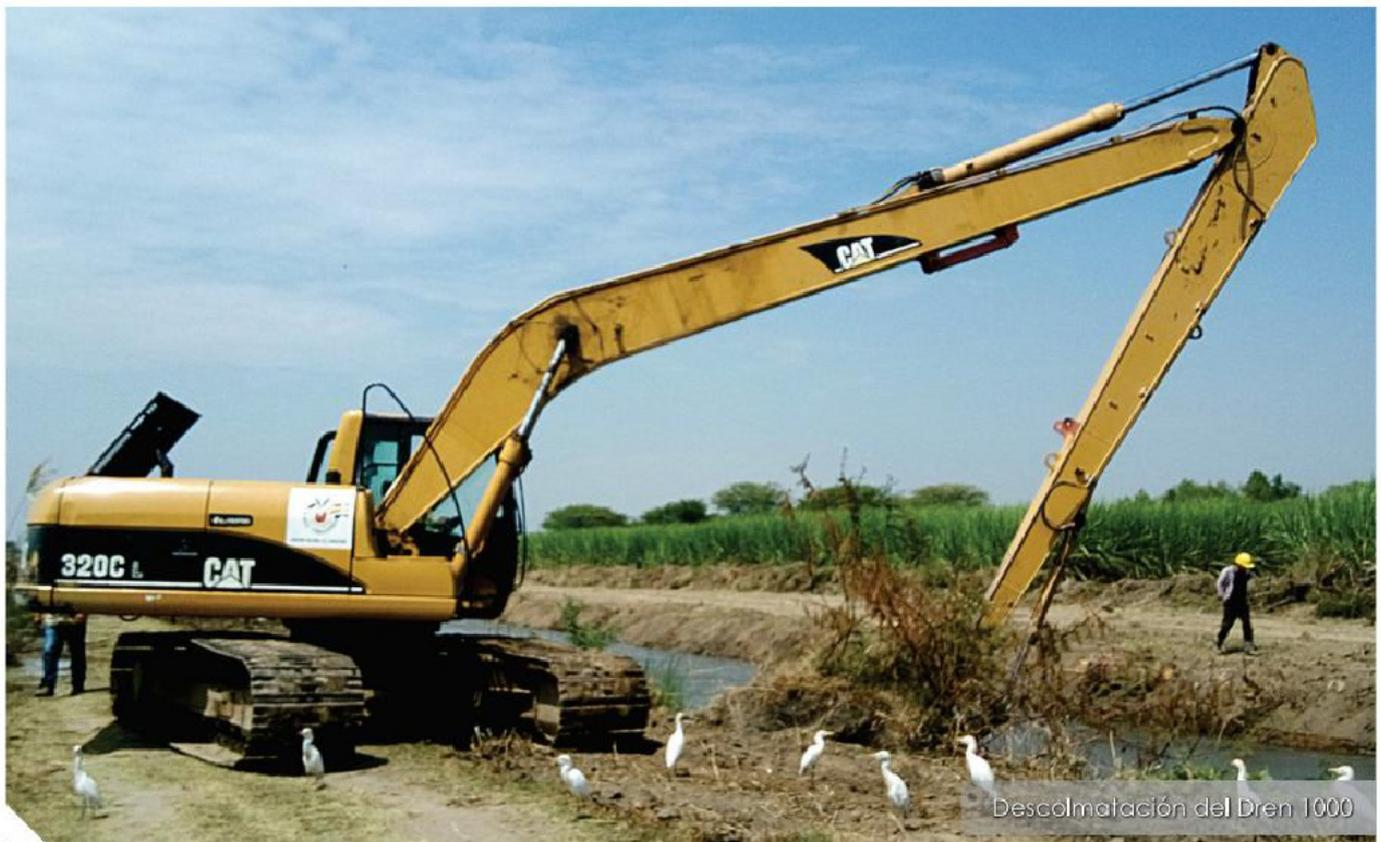
Taymi a lo largo de sus 48.8 km. Los trabajos comprendieron la limpieza y descolmatación de la caja del canal, resane de fisuras, la reposición de mampostería en los cruces de las quebradas Río Loco, sector La Piña y en el sector Balazo, así como la construcción de una caseta.
